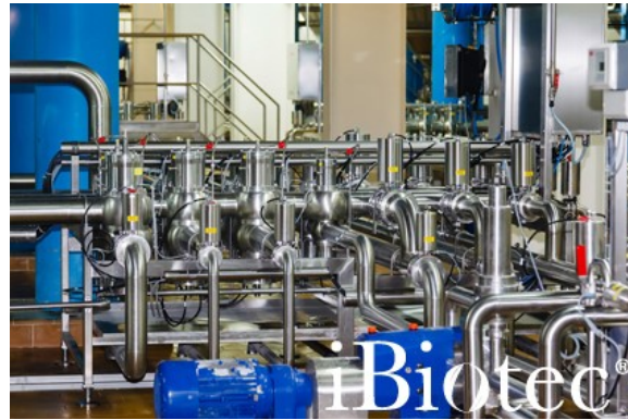
Reinigung von Rohren
